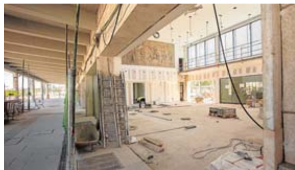
Vista del vestíbulo principal desde el andén. JORGE REY
